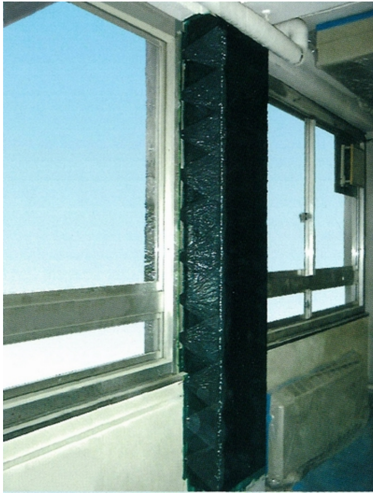
柱の補強事例
