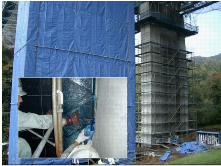
I型断面橋脚壁部の補強事例
